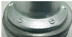
Nach der Installation
